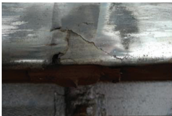
Slika 6. Prslina u squat defektu i lokalno udubljenje kod aluminotermijskog zavora
